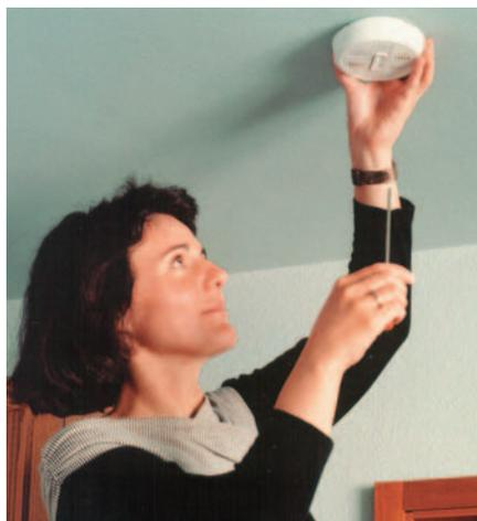
Regeln für den Einbau, Betrieb und die Instandhaltung von Rauchmeldern sind in DIN 14676 festgelegt.
